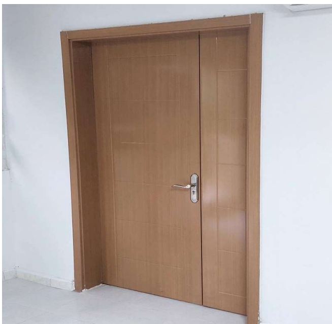
Image 5. Porte installée à la salle de réunion/formation du UNHCR à Nouakchott
