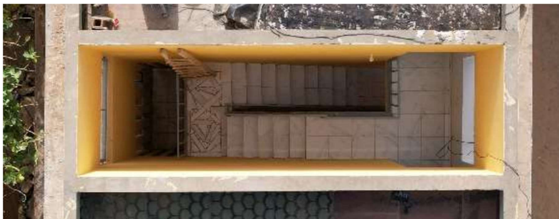
Image 16. Vue aérienne de l'escalier du bâtiment « extension 1 » de la Guest House
